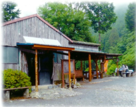
軒上の太陽電池(12V 100W×2)
