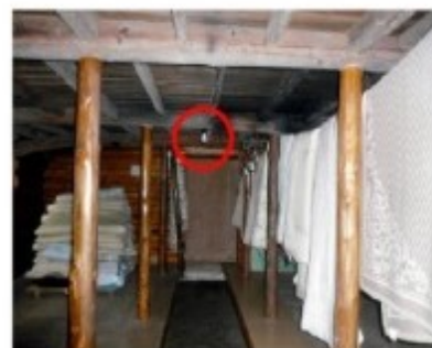
1階就寝室LED=4.9V (写真) 出入口壁=深夜残置灯LED=1.4V (写っていない)
