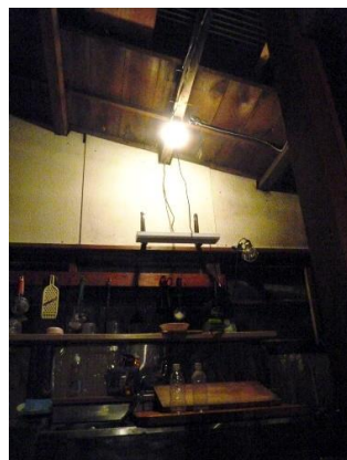
【本館台所のLED照明】
